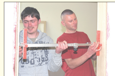
- Einsetzen einer Tür in das von Teilnehmern geplante und umgesetzte Internetcafe -
