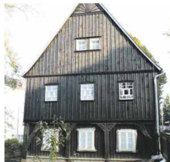
Die letzten Sanierungsarbeiten im Heimatmuseum Großröhrsdorf werden bis zum Herbst 2015 abgeschlossen sein. Dann sind Dach, Fassade und Grundmauern für die nächsten 100 Jahre auf einen soliden Bauzustand gebracht.
