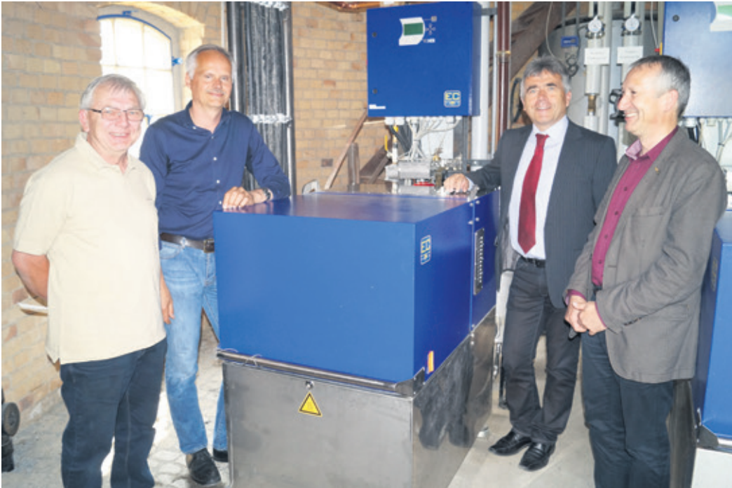
Zu einem der interessantesten Gebäude in Weißenberg zählt der Wasserturm. Hier wurde im Jahr 2011 eine „Energiezentrale“ eingebaut. Nicht nur Wärme wird von dort an die umliegenden Gebäude und die Schule geliefert, sondern auch ein erheblicher Teil des benötigten Stromes für die öffentlichen Gebäude in der Oberstadt. Herzstück ist ein Blockheizkraftwerk, das aus Erdgas Strom und Wärme produziert. Hagen Staude von der Heizung- und Metallbau Staude GmbH (z.v.l.) erläutert Stadtrat Jens Sterzel, Landrat Michael Harig und Bürgermeister Jürgen Art (v. l.) die Eckdaten.
