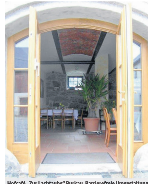
Hofcafé „Zur Lachtaube“ Burkau, Barrierefreie Umgestaltung des Eingangsbereichs und des Innenraums im ehemaligen Kuhstall
