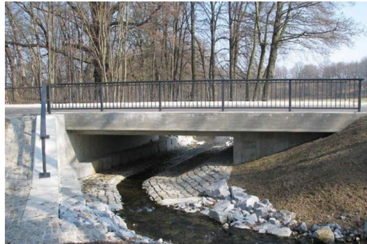
Nach dem Hochwasserschaden wieder neu aufgebaut: Brücke auf der K 7227 bei Rodewitz
