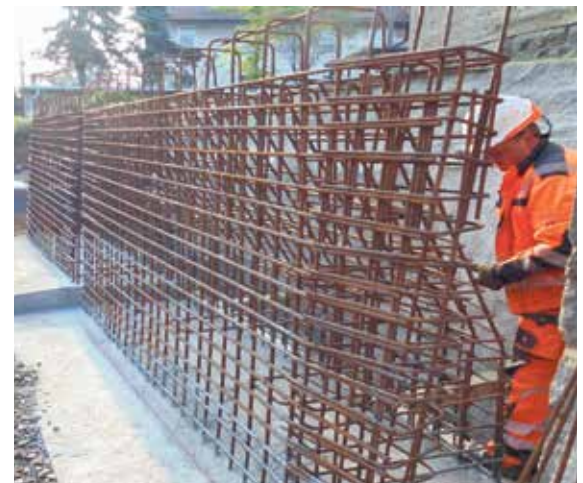
Schal- und Bewehrungsarbeiten für Stützwand
