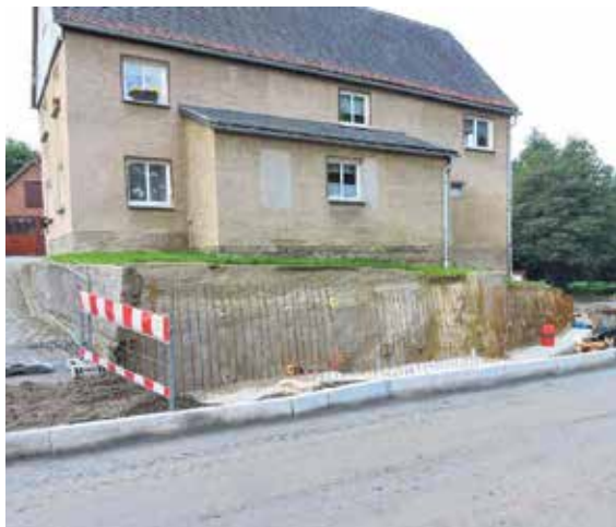
Stützwand- und Böschungssicherung durch Rückverankerungen
