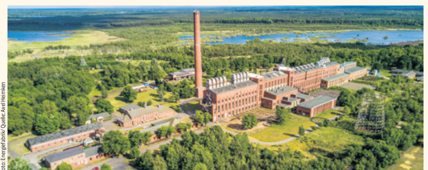
Foto: Energiefabrik/Quelle: Axel Heimken
