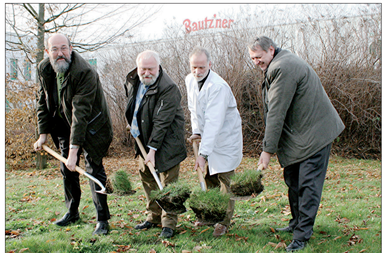
Bautzens Baubürgermeister Peter Hesse, Oberbürgermeister Christian Schramm, Werkleiter Jörg Dietlein und Michael Pilz, Leiter des Geschäftsbereiches Optionsbehörden und Arge im Landratsamt Bautzen beim gemeinsamen ersten Spatenstich
