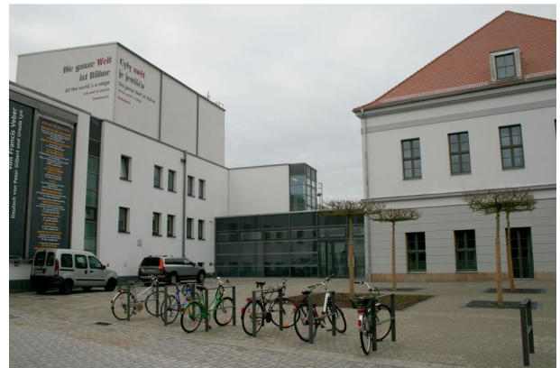
Über den neuen Verbindungsgang können die Schauspieler vom Haupthaus (links) trockenen Fußes zu den Funktionsräumen in der Societät (rechts) gelangen.
