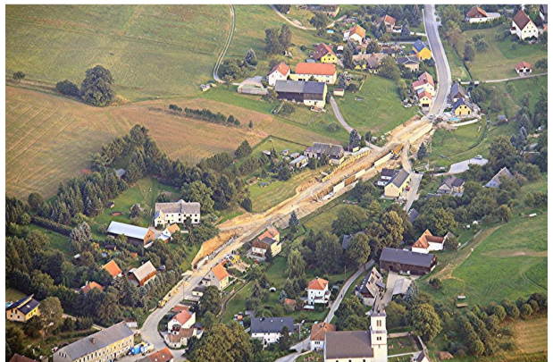
Die Luftaufnahme zeigt, wie schwierig es ist, einen grundhaften Ausbau in einem fast nur über eine Durchgangsstraße erschlossenen Ort durchzuführen. Die Anforderungen sowohl an Anlieger als auch an Bauleute sind in einem solchen Fall besonders hoch. Foto: Rolf Karsch
