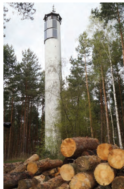
Feuerwachturm Hahneberge mit autarker Stromversorgung und Richtfunkübertragung
