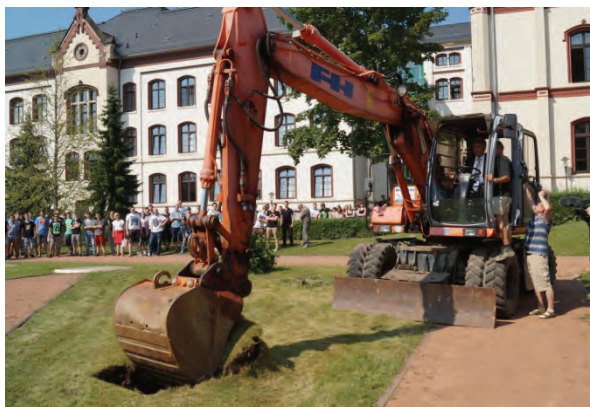
Landrat Michael Harig nahm den 1. Spatenstich eigenhändig mit dem Bagger vor.
